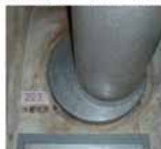
貫通部の止水処置(例)
